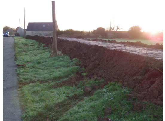
Création d'un talus avec de futures plantations de 100ml chez Mme Derrien Marie-Pierre au lieu-dit Place Martin pour la reconstruction du bocage breton.
